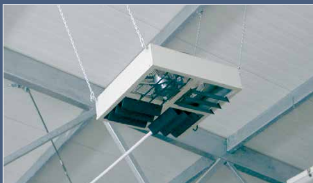
установка подпотолочного вентилятора
